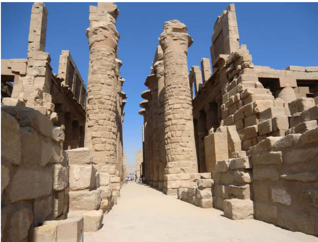
Des bâtiments alignés avec le passage du Soleil
